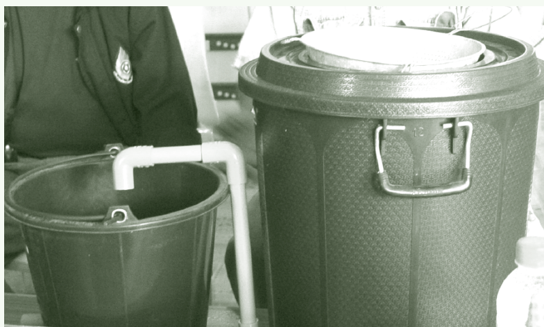
รูปที่ 2.6 บ่อดักไขมันแบบครัวเรือน
